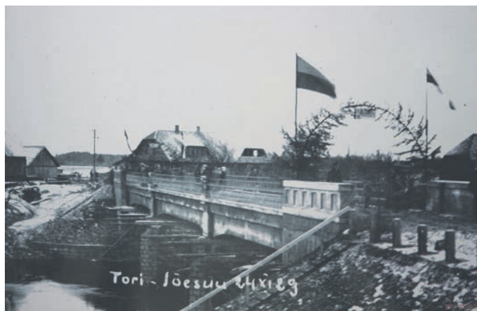
Jõesuu betoonsilla avamine 24. novembril 1929
